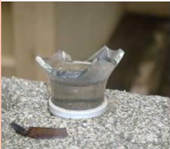
防竊盜圍牆碎玻璃
