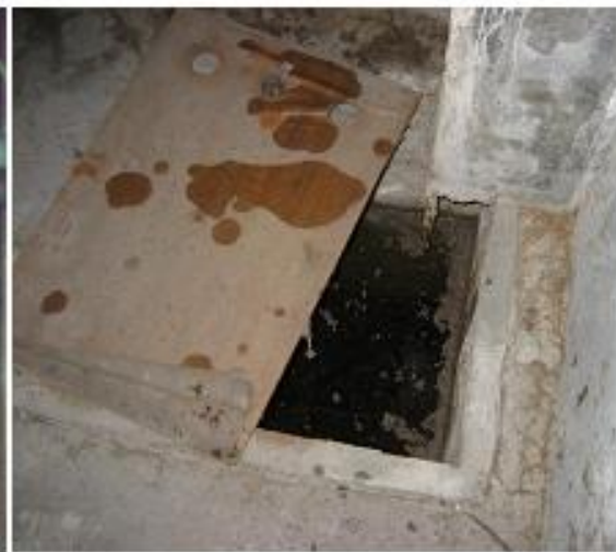
地下室污水池
