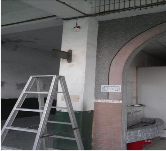
閃光喇叭施工後
